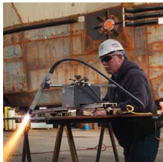
Резка и строжка по рельсовым направляющим
